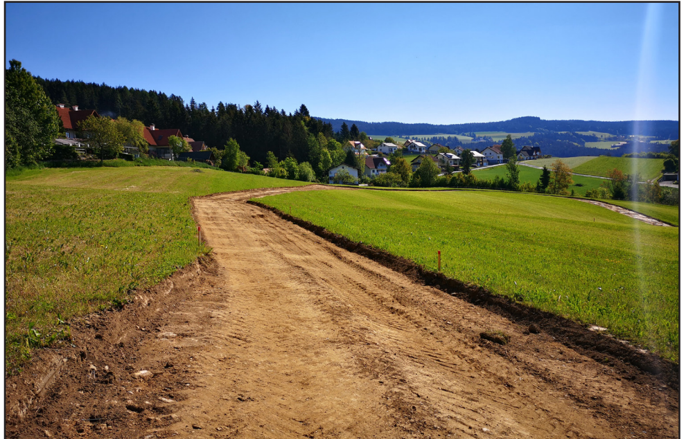
In die neue Siedlungsstraße wird sämtliche Infrastruktur verlegt.
