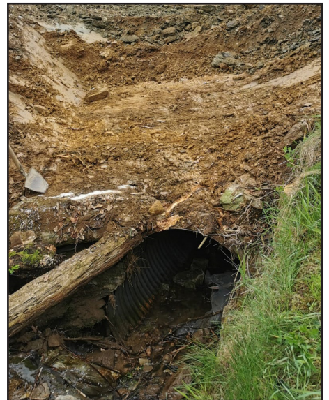
Die großen Durchlässe an den Bächen wurden bereits versetzt.
